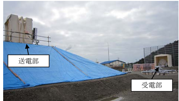
第 2 図 屋外試験状況
